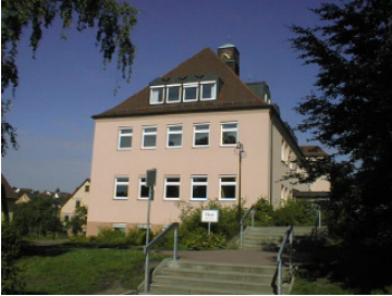
Grund- und Hauptschule in Markt Heroldsberg
