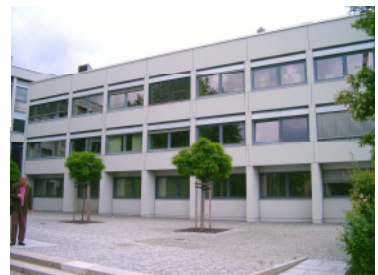
Staatliches Ämtergebäude in Nürnberg
